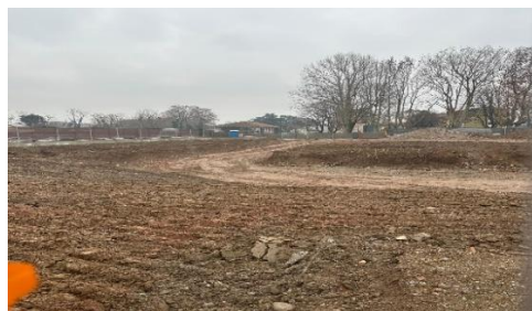
Foto 3 area cantiere ex carcere
