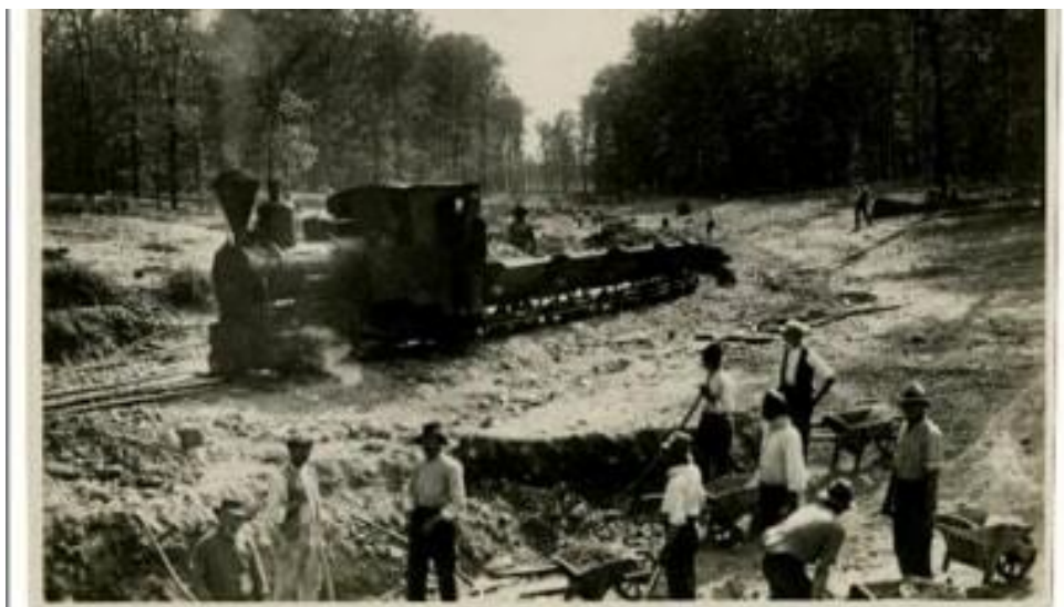
I lavori in autodromo nel 1922 ( https://www.monzatoday.it/attualita/autodromo-storia_costruzione.html )
